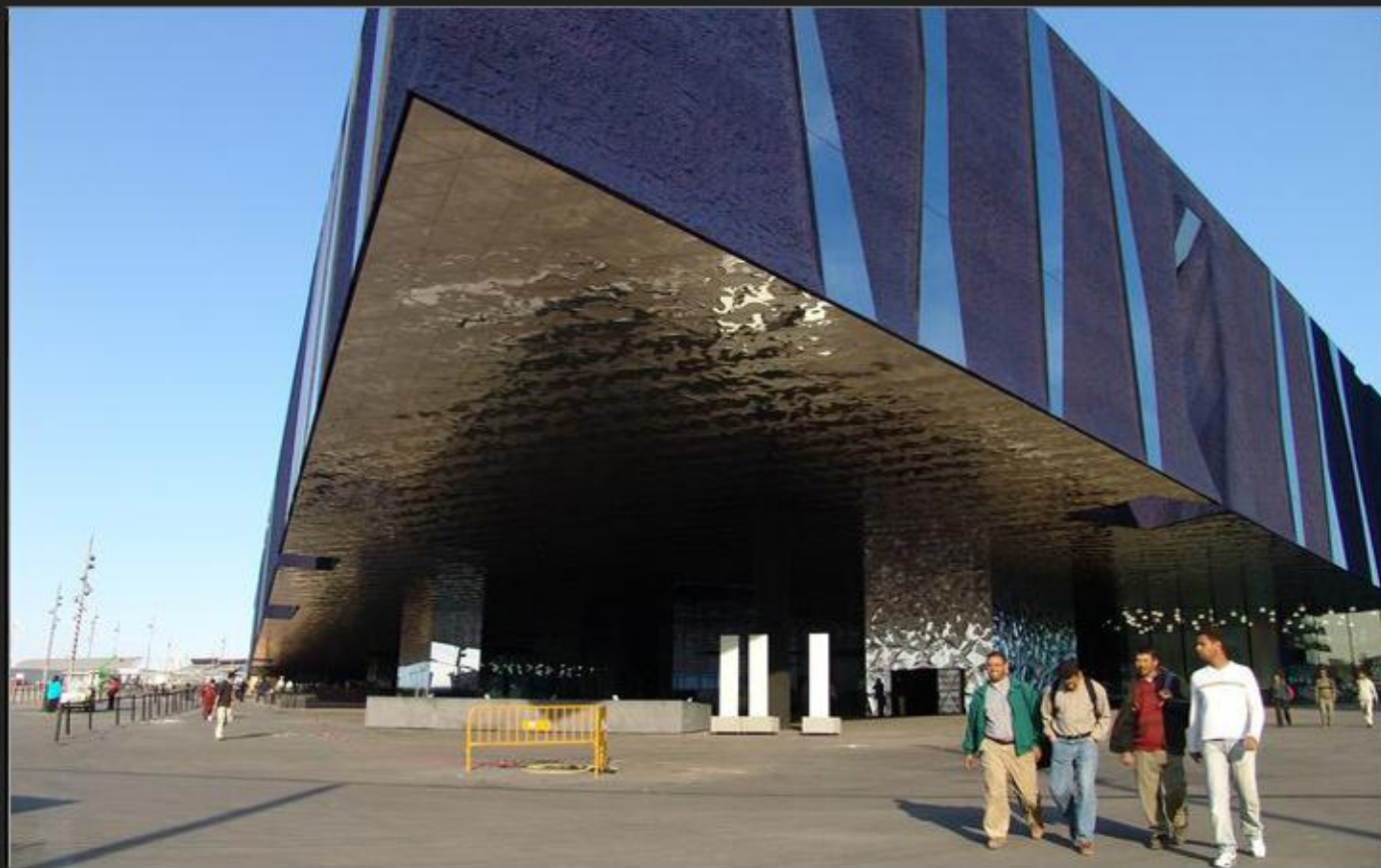
Барселона, Испания Форум Edifici, внешняя отделка, суперзеркало N8 INOX-FORM B – золото, кобальтовый синий INOX-SPECTRAL®
