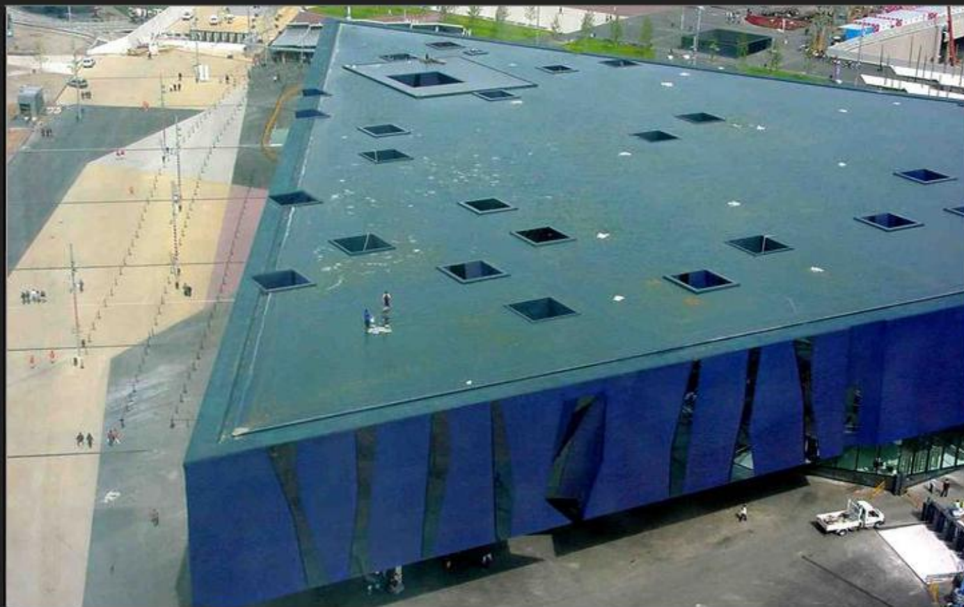
Барселона, Испания Форум Edifício, внешняя отделка, суперзеркало N8 INOX-FORM B – золото, кобальтовый синий INOX-SPECTRAL®
