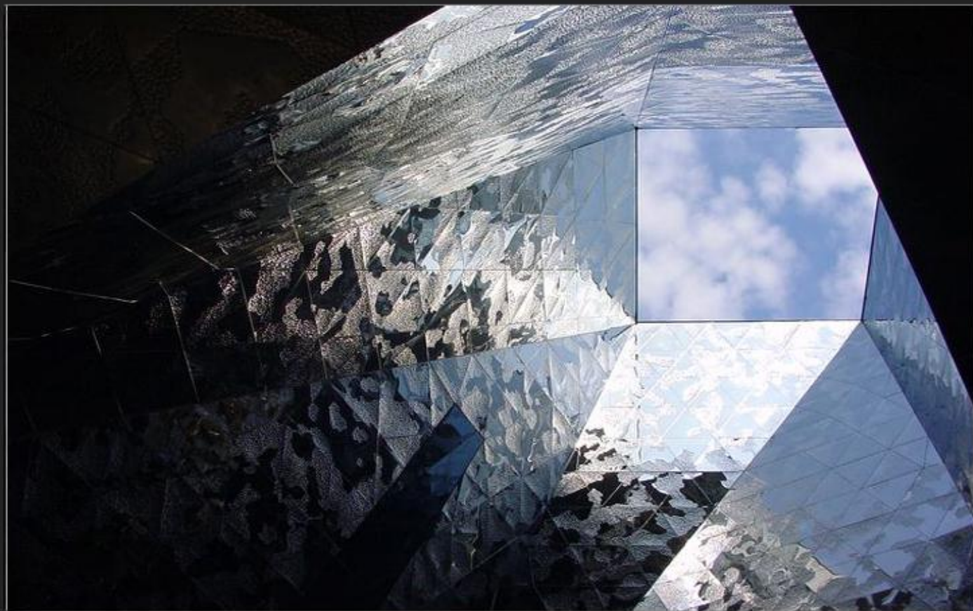
Барселона, Испания Форум Edifici, внешняя отделка, суперзеркало N8 INOX-FORM B – золото, кобальтовый синий INOX-SPECTRAL®
