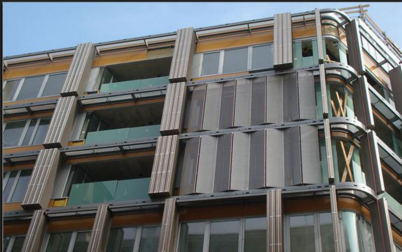
Вена, Австрия Жилое здание, солнцезащитные элементы, 4/4 цельнотянутые решетки – шампань INOX-SPECTRAL®
