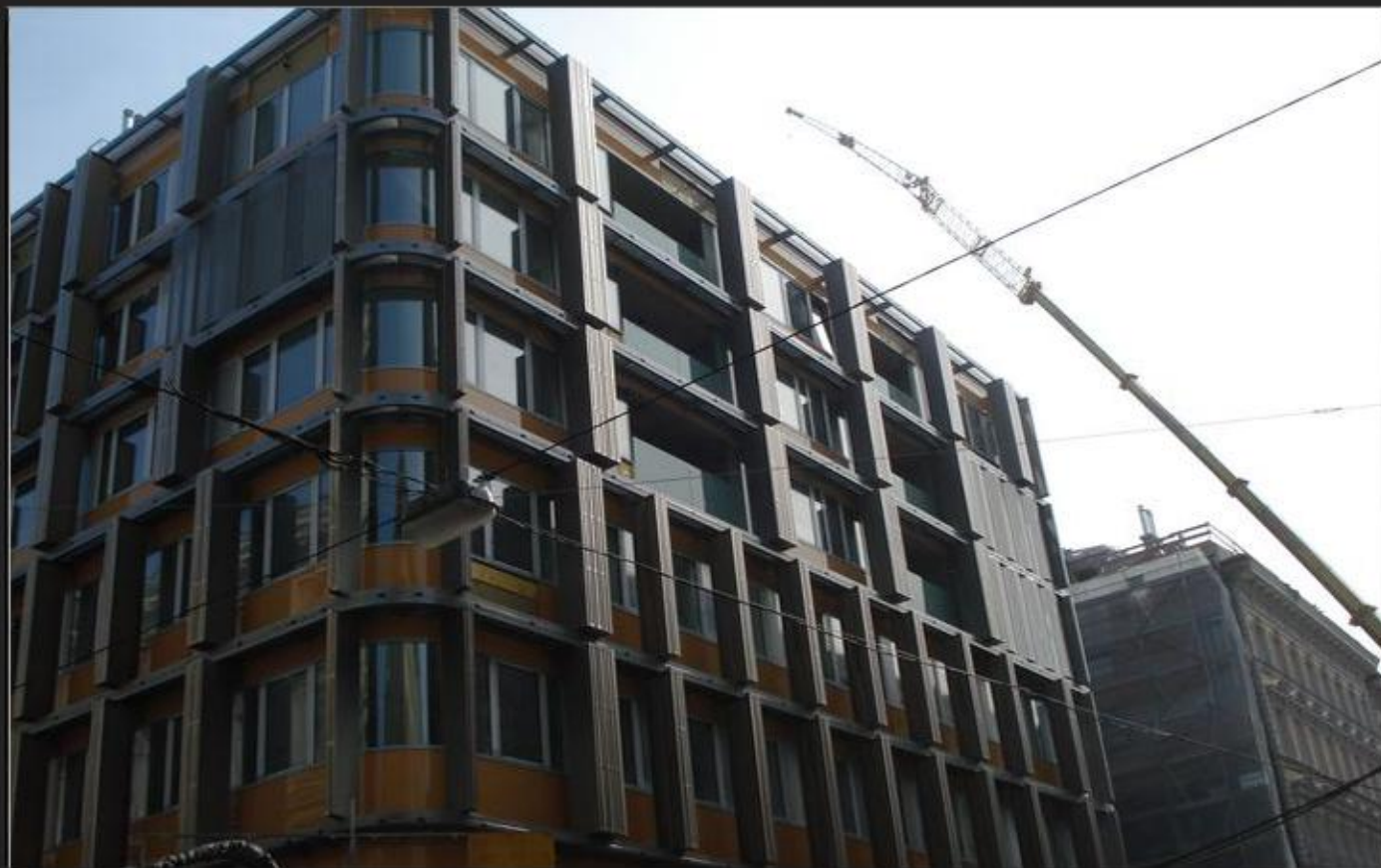
Вена, Австрия Жилое здание, солнцезащитные элементы, 1/4 цельнотянутые решетки – шампань INOX-SPECTRAL®
