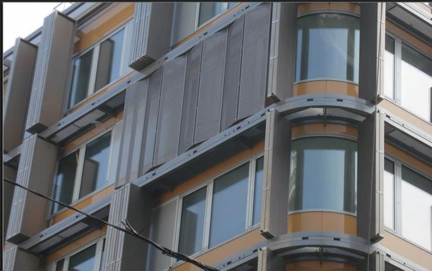
Вена, Австрия Жилое здание, солнцезащитные элементы, 2/4 цельнотянутые решетки – шампань INOX-SPECTRAL®
