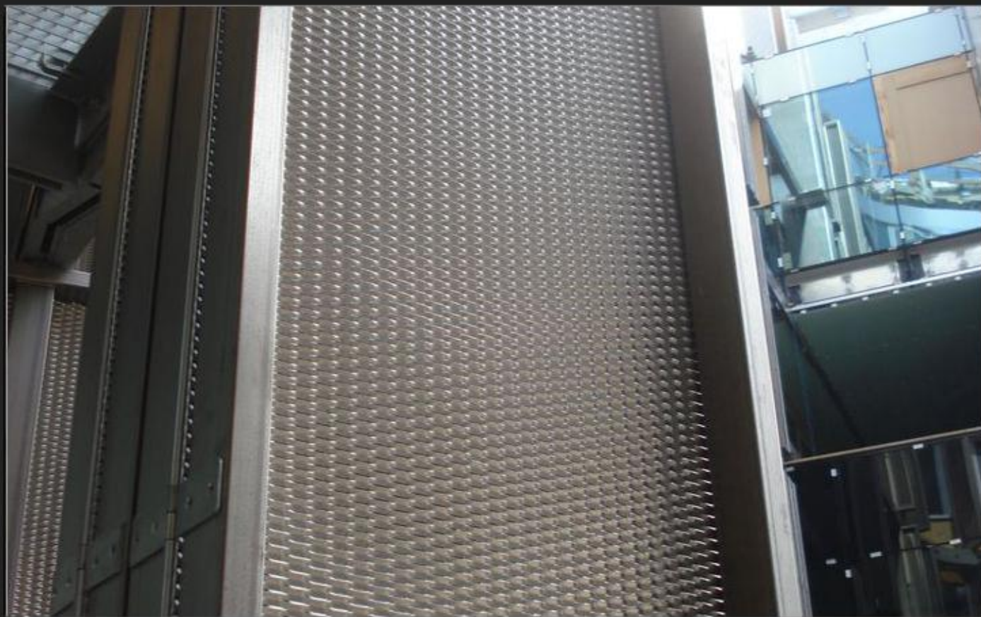
Вена, Австрия Жилое здание, солнцезащитные элементы, 3/4 цельнотянутые решетки – шампань INOX-SPECTRAL®
