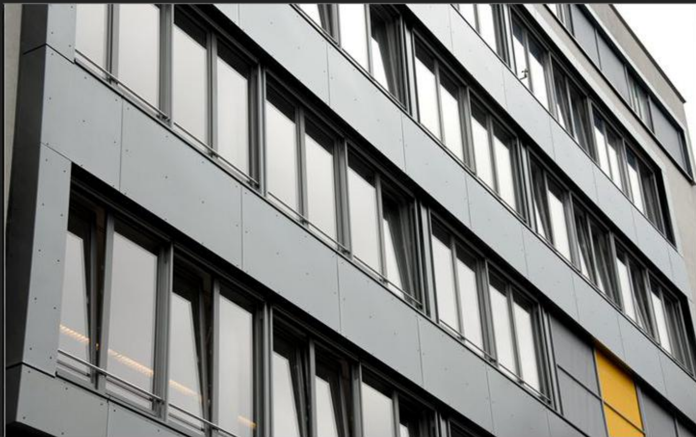
Гамбург, Здание школы Фасад, шлифованный K240 - черный INOX-SPECTRAL®
