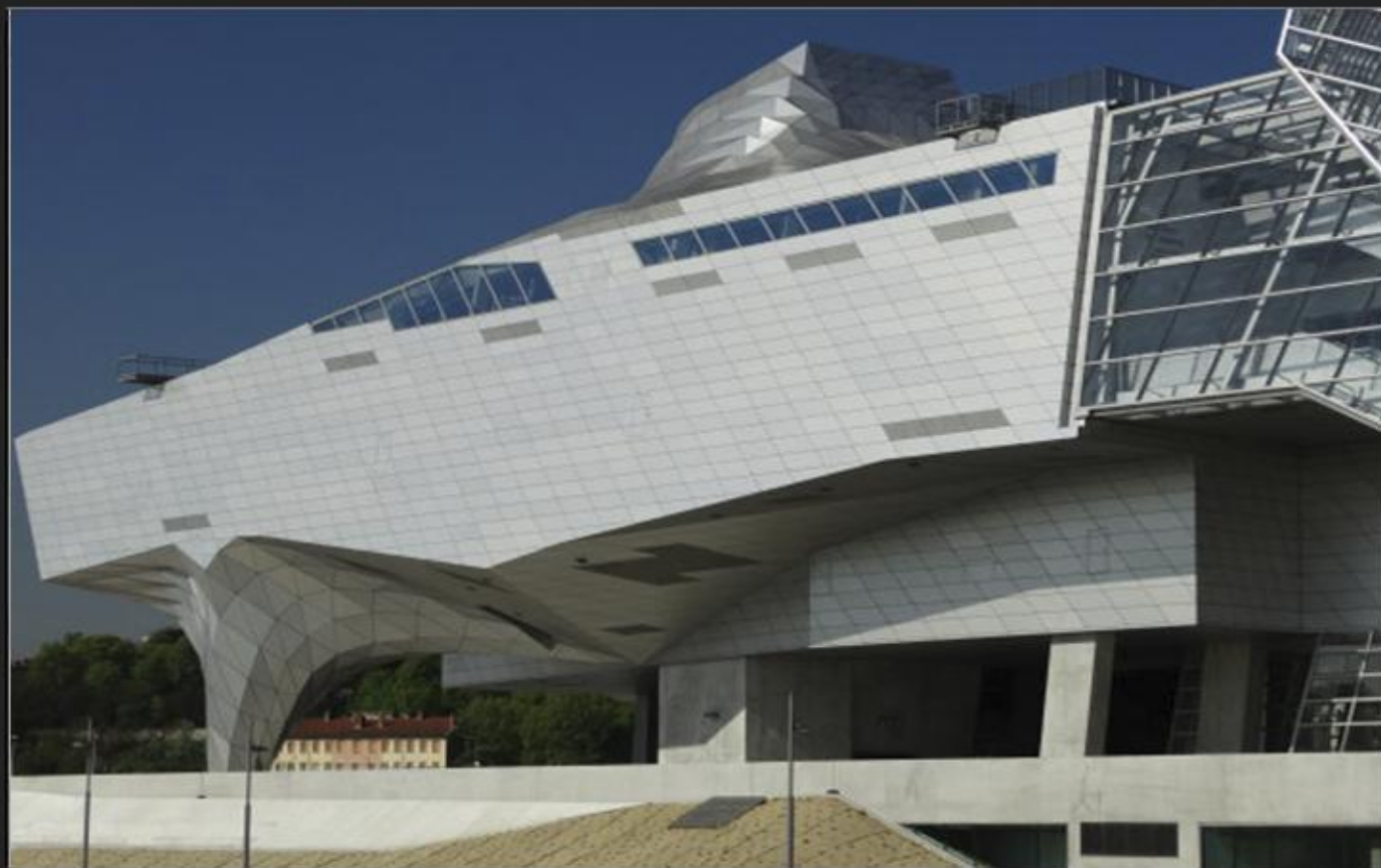
Лион, Франция Музей Слияния, фасад, струйная обработка EG7, выполнен компанией Design Factory
