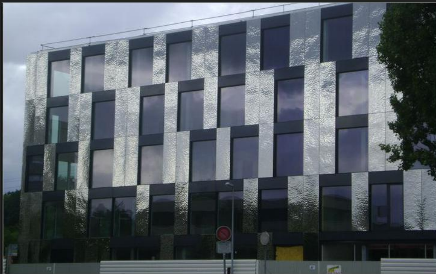
Лозанна, Швейцария Офисное здание, элементы фасада, INOX-FORM M
