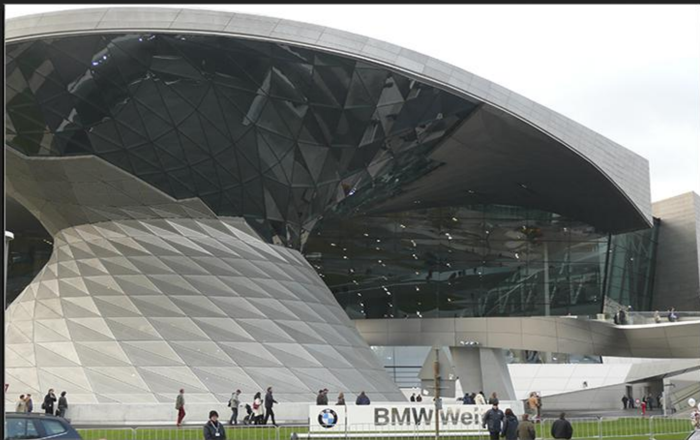
Мюнхен, Мир BMW Фасад, перфорация – струйная обработка EG7, выполнен компанией Design Factory
