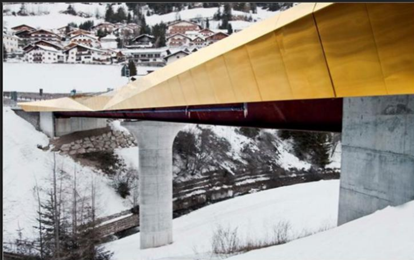
Санта Кристина, Италия, Мост, внешняя облицовка, шлифованный HL-TiN золото, выполнен компанией Design Factory
