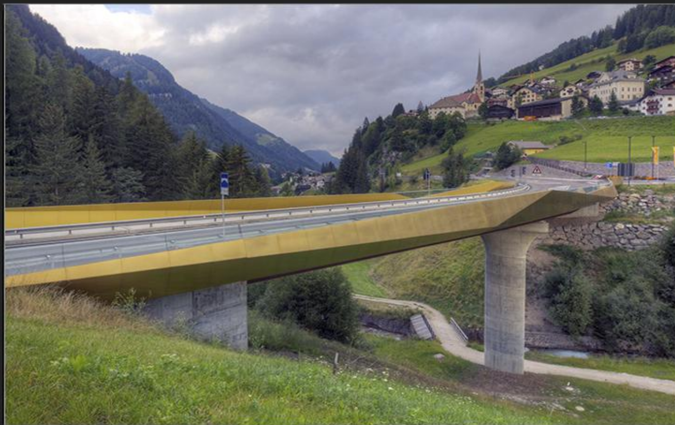
Санта Кристина, Италия, Мост, внешняя облицовка, шлифованный HL-TiN золото, выполнен компанией Design Factory
