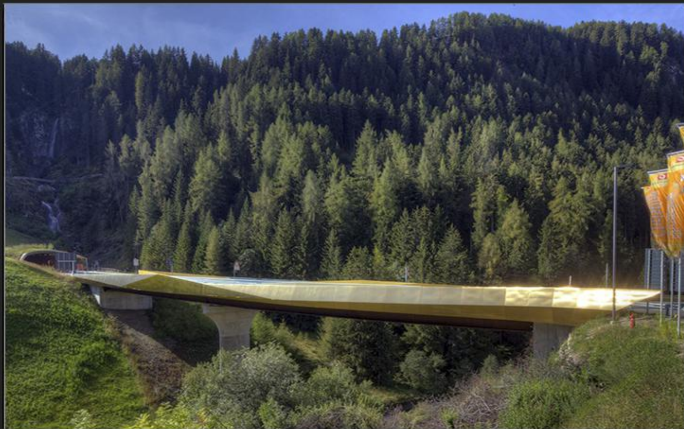
Санта Кристина, Италия, Мост, внешняя облицовка, шлифованный HL-TiN золото, выполнен компанией Design Factory
