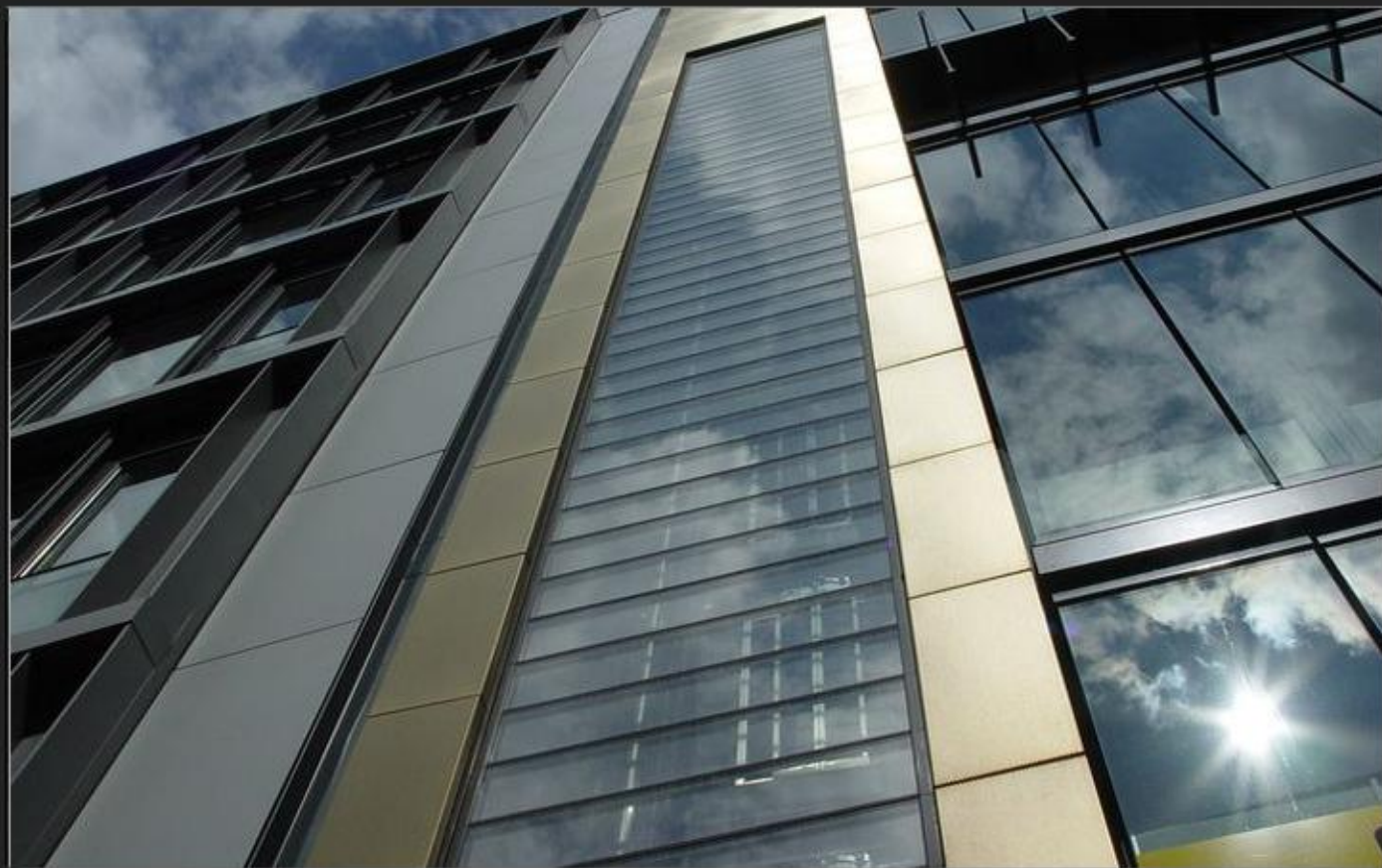
Гамбург, Офисное здание Фасад, 6WL - золото INOX-SPECTRAL®
