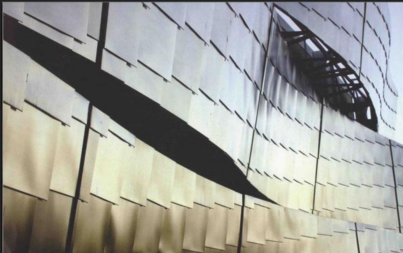
Перпиньян, Франция Мусоросжигательный завод, фасад, INOX-UT - шампань INOX-SPECTRAL®
