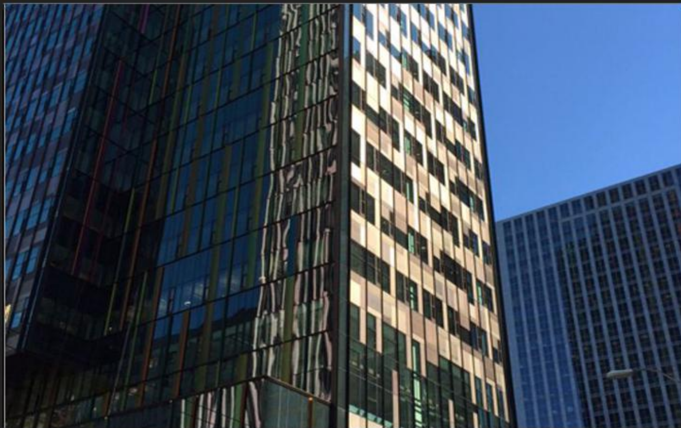
Сиэтл, США Офис Amazon, фасад, 2B – специальный цвет пшеничный, красный, зеленый INOX-SPECTRAL®
