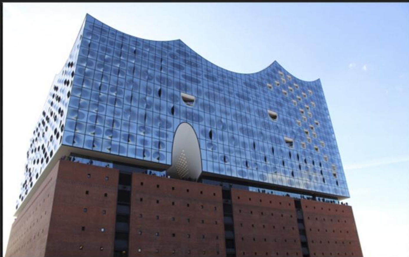
Гамбург, Филармония Фасад, суперзеркало N8, выполнен компанией Design Factory
