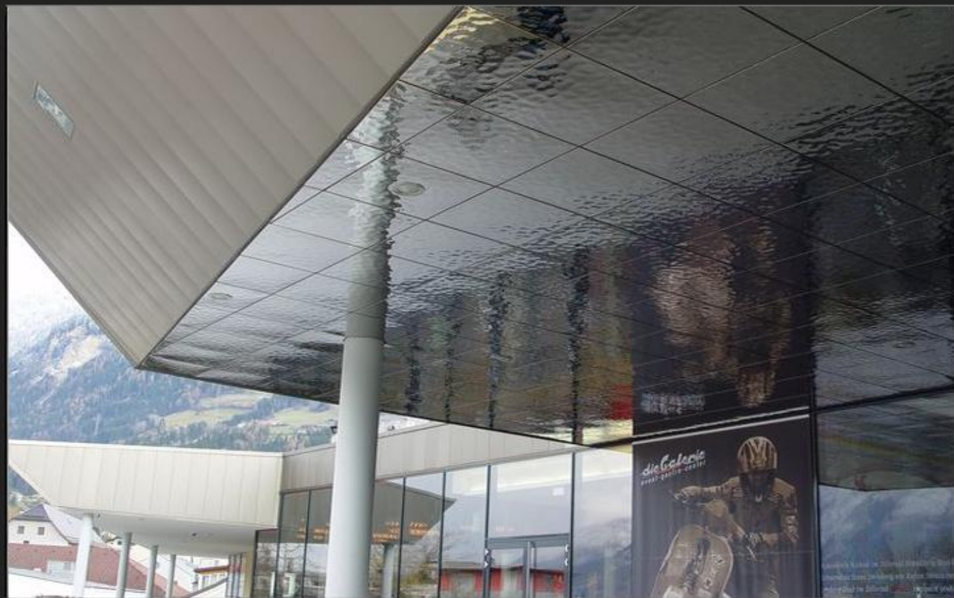
Швац, Австрия S-Zentrum, облицовка потолка, зеркало N7 INOX-FORM M
