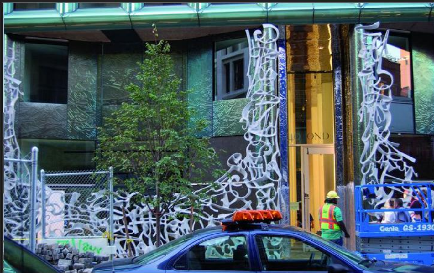
Нью Йорк, США Апартаменты 40 Bond, Входная зона, зеркало N8, INOX-FORM перфорация, зерно INOX-FORM N6 – зеленый зашлифованный INOX-SPECTRAL®
