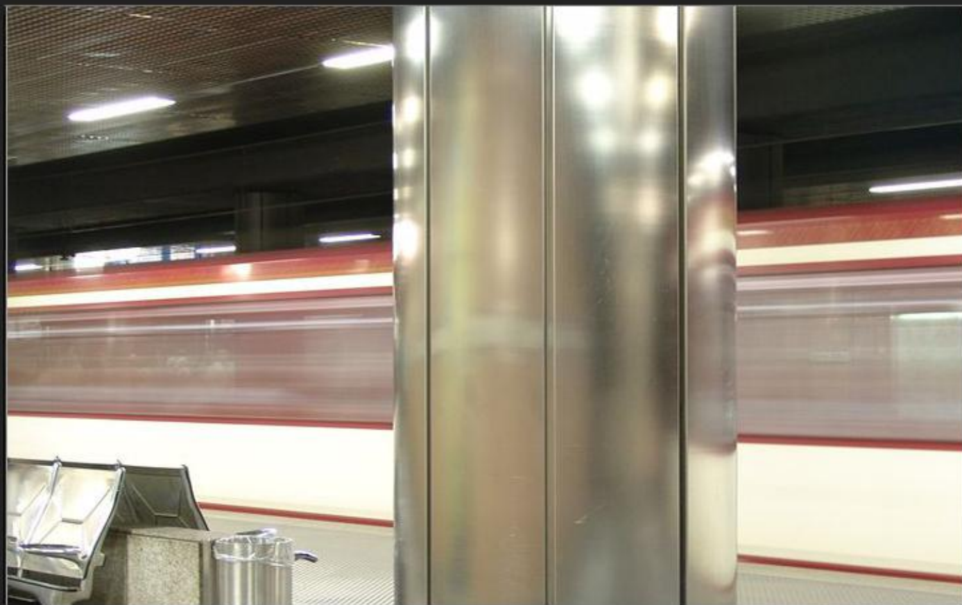
Дюссельдорф, Германия Станция метро, облицовка колонн, шлифованный K240 – INOX-TEC
